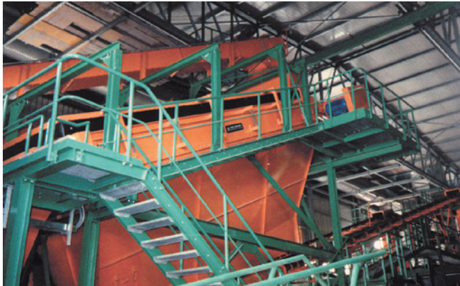
■コンポスト設備 納入機種：LF-2.0-7.56/24ED 【能力】5～50t/h 【分離径】4～20mm 【水分】30～50%
