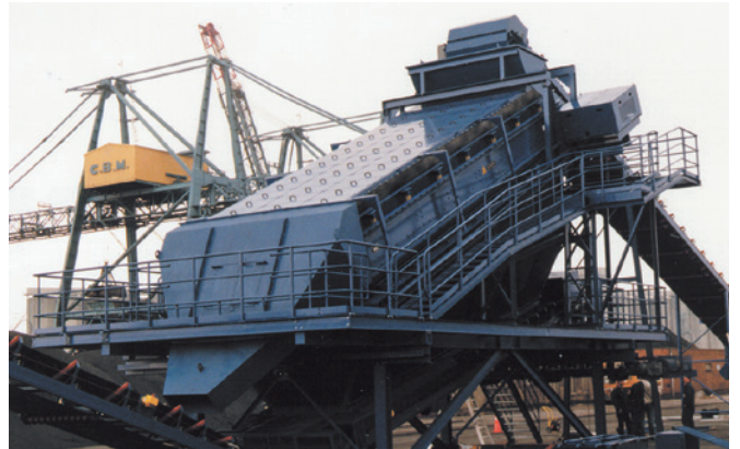
■石炭設備 納入機種：LF-3.0-8.82/28ED 【能力】20～1200t/h 【分離径】2～40mm 【水分】10～60%
